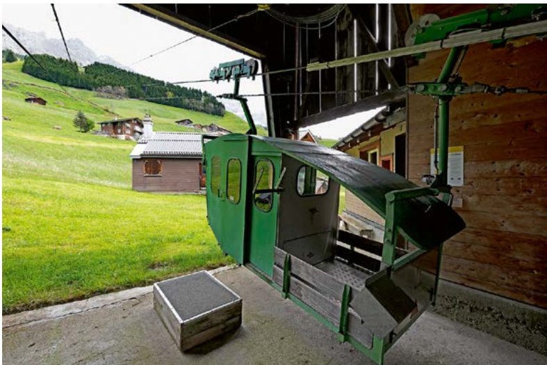
Talstation der Seilbahn Kipfen-Tristel.
